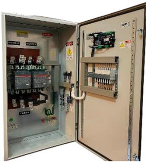
El tablero de transferencia automático modelo PE-200 (220V) está formado por contactores magnéticos con opción en transferencia a doble tiro, y este, tiene la función de hacer la transferencia y retransferencia de la carga de la red de CFE a la planta y viceversa por medio del módulo de control DSE-4520 o DSE 7320. Todo esto de forma automática o manual.
